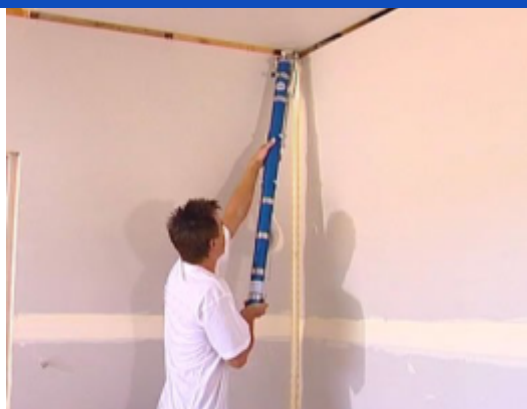
Aplicare banda de imbinare si pasta la unghi interior
